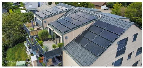
So sehen die Kollektoren aus: Seit Dezember 2020 versorgt die PVT-Wärmepumpenanlage sechs Wohnungen mit einer Gesamtfläche von 560 m² in Heitersheim bei Freiburg mit Strom und Wärme
